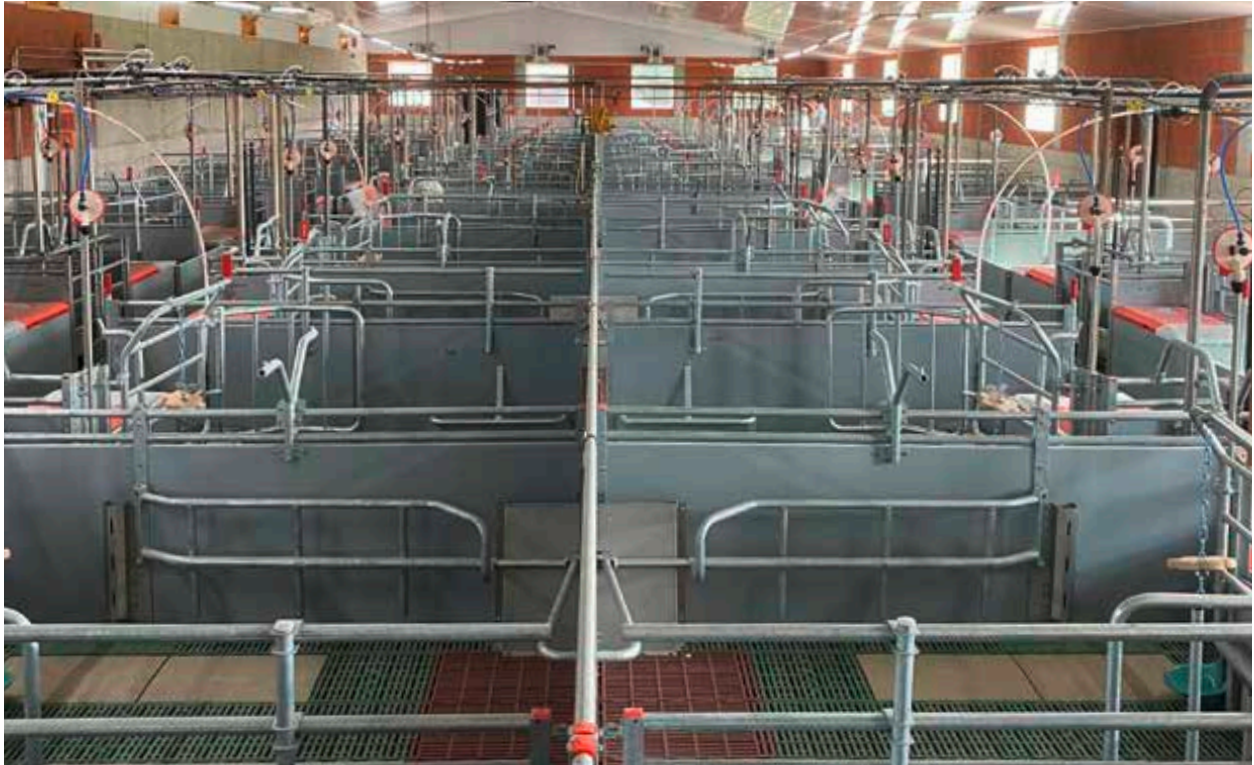
Bild 120: Innenansicht Abferkelstall, große Abferkelabteile
