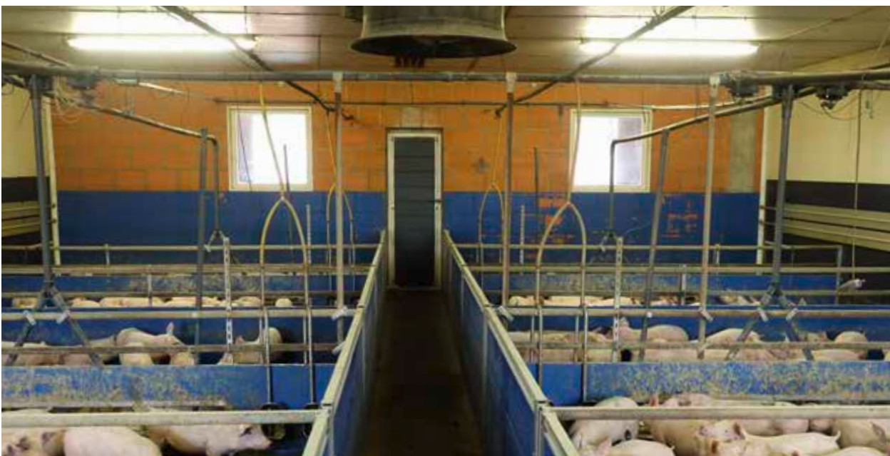
Bild 134: Oberflurabsaugung ist wegen geringerer Investitionskosten verbreiteter.
