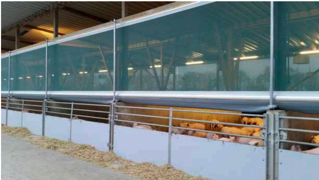
Bild 113: Offene Außenwände, Windbrechnetze, lassen Licht und Luft in den Stall.
