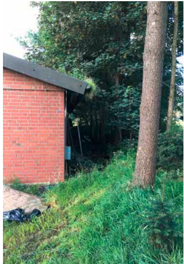
Bild 144: Beschattung der Traufe verhindert zusätzlichen Wärmeeintrag im Sommer
