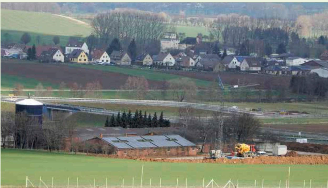
Bild 123: Bei Neu- und Umbauten müssen ausreichende Abstände zur Wohnbebauung eingehalten werden.
