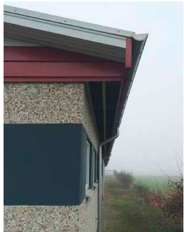
Bild 140: Traufausbildung mit Dachüberstand zur Beschattung und zum Schutz der Wand
