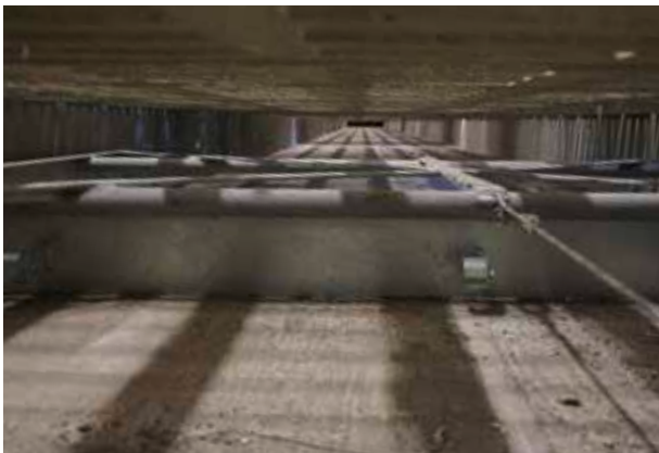
Bild 138: Seilzugchieber als Unterflurentmistung
