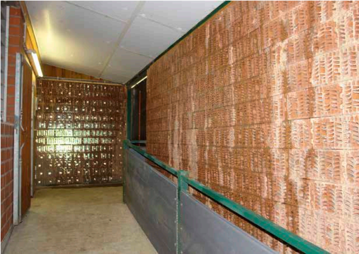
Bild 141: Kühlung durch wasserberieselte Porotonsteinwand, innen
