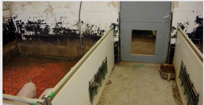
Abbildung 12: Türganglüftung (Quelle: MuD Tierschutz © BLE)
