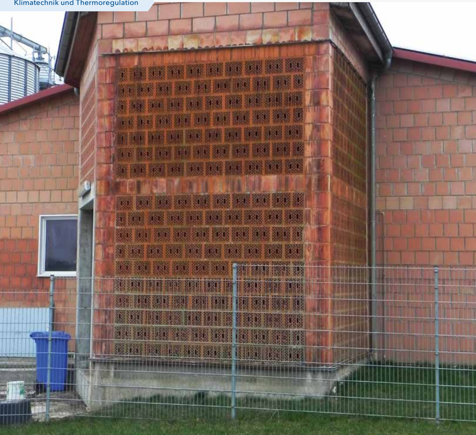
Abb. 45: Kühlturm an einem Schweinemaststall
