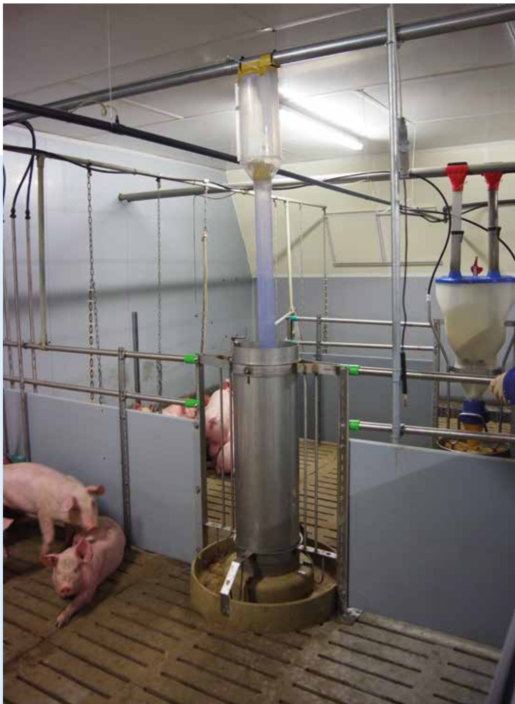
Abb. 67: Automatische Raufuttergabe von z.B. Pellets mittels Rohrkettenverteilung
