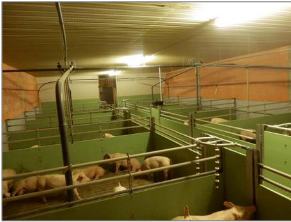
Bild 6: diffuse Deckenlüftung, Abteilansicht
