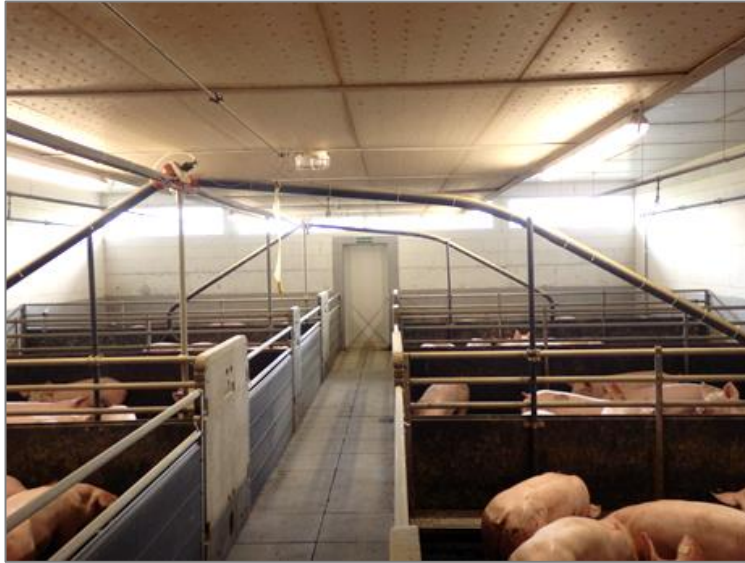
Bild 5: Rieselkanallüftung mit mittig im Abteil liegendem Kanal
