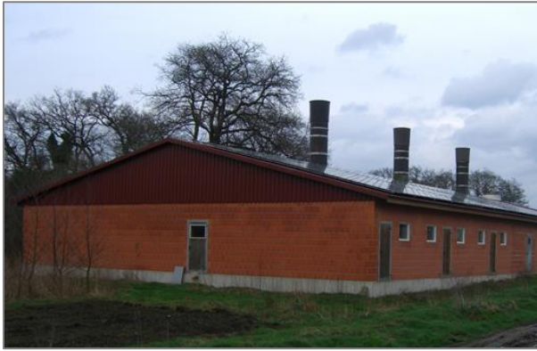
Bild 21: Außenansicht eines Stalles mit Einzelabsaugung
