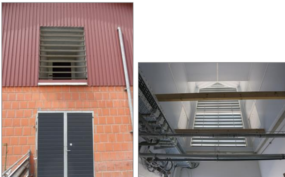
Bild 2: Frischluft gelangt über Giebelklappen in den Stall (links Außenansicht/ rechts Innenansicht)
