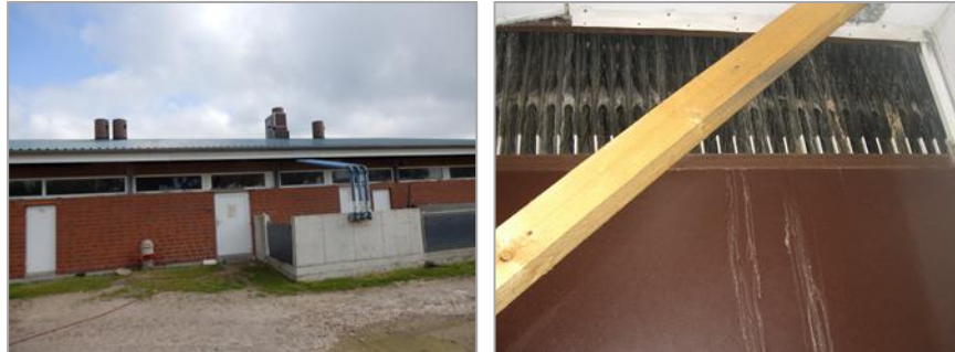
Bild 30: Luft-Luft Wärmetauscher Zuluftseite
