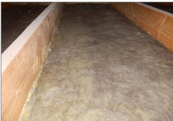
Bild 7: Schichten der diffusen Decke im Dachraum
