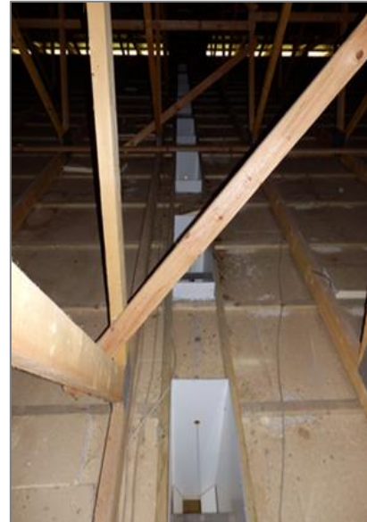
Bild 14: Schlitzganglüftung mit Deckenelementen (links Abteilansicht / rechts Dachraumansicht)
