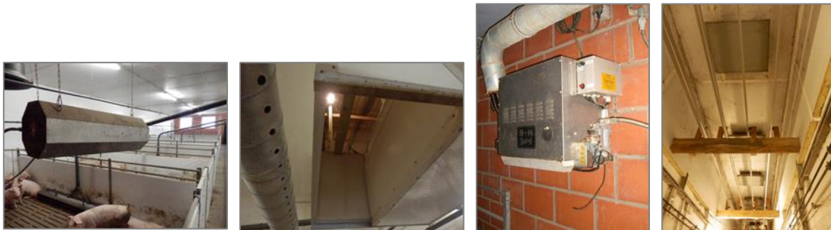
Bild 28: verschiedene Heizsysteme für Schweineställe (Gaskanone, Wickelfalzrohr, Warmluftkonvektor, Twinrohre)
