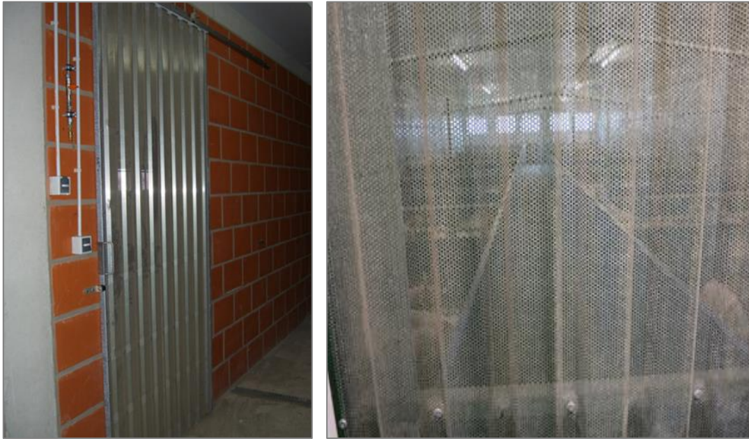
Bild 11: Türganglüftung mit Lochblechtür
