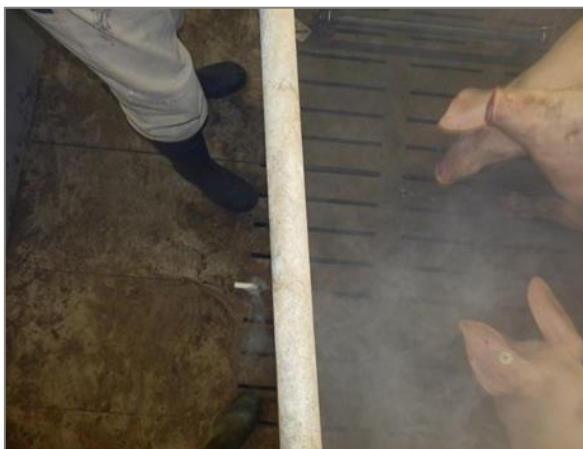
Bild 37: Abdichten des Spaltenbodens auf dem Treibegang bei der Schlitzganglüftung
