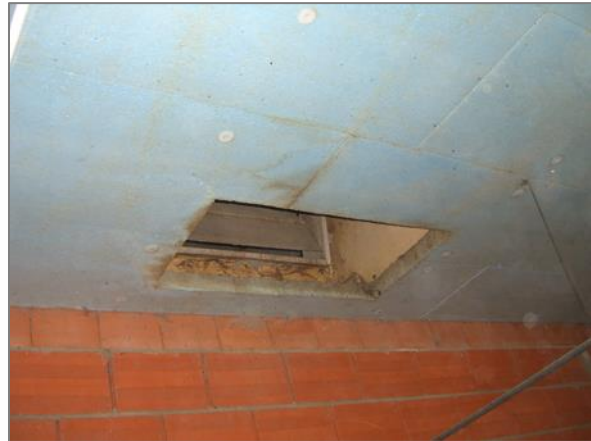
Bild 33: deckengleicher Absaugpunkt
