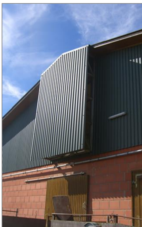
Bild 4: Giebelklappen mit Windschutz
