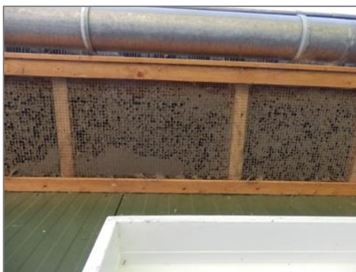
Bild 34: Reinigung des Traufgitters
