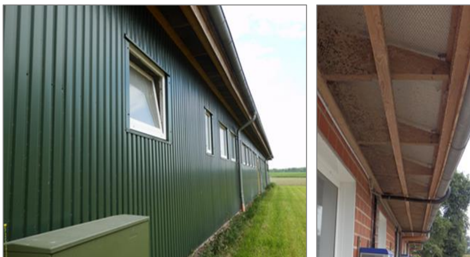
Bild 1: Frischluft gelangt über die Traufe in den Stall
