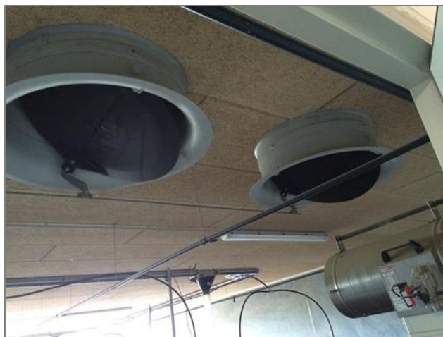
Bild 8: diffuse Decke mit Holzwolle-Zementplatten
