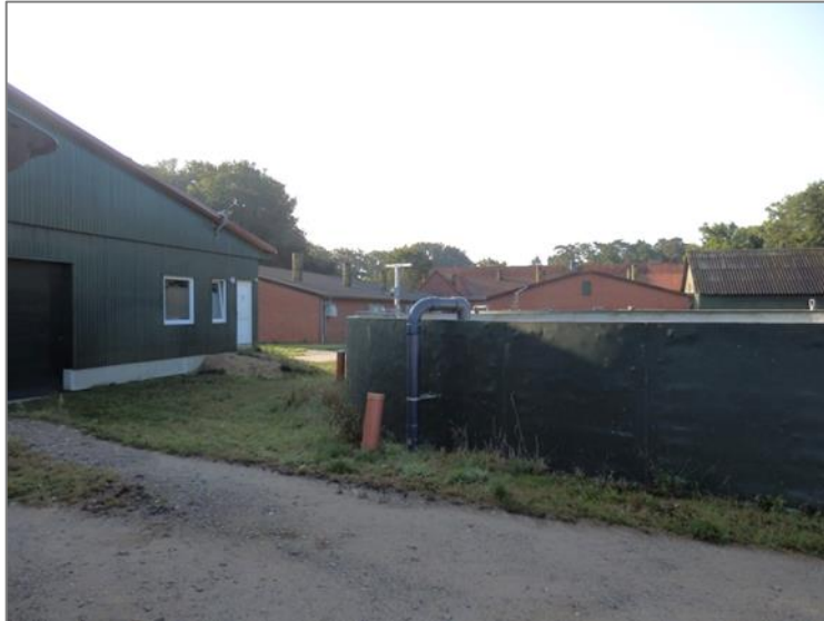
Bild 38: Güllebehälter in Hauptwindrichtung zum Zulufttritt des Stalles
