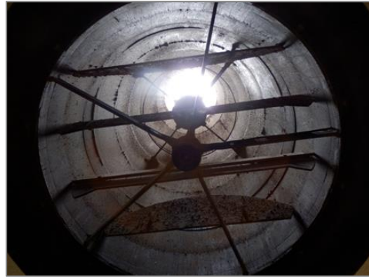
Bild 22: Blick in den Abluftschacht einer Einzelabsaugung
