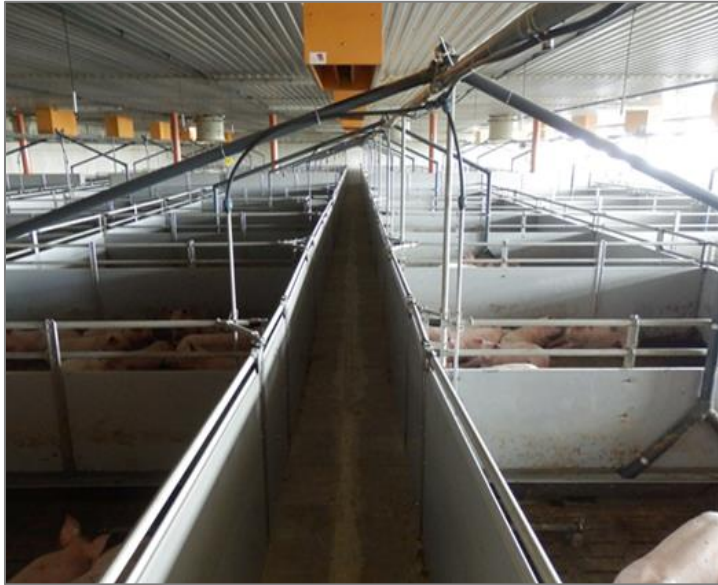
Bild 14: Schlitzganglüftung mit Deckenelementen (links Abteilansicht / rechts Dachraumansicht)
