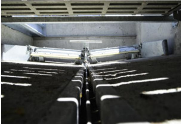
Unterflurschieber im Auslauf eines Mastschweinestalles
