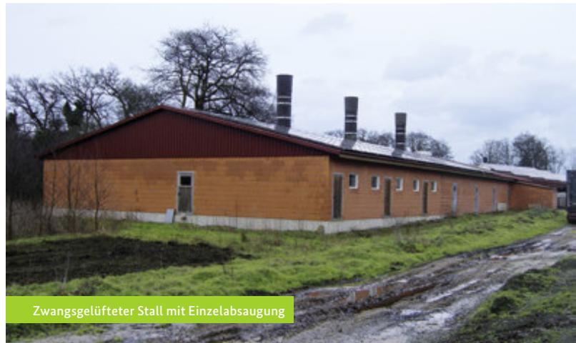
Zwangsgelüfteter Stall mit Einzelabsaugung
