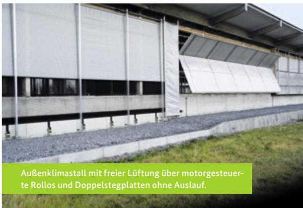
Außenklimastall mit freier Lüftung über motorgesteuerte Rollos und Doppelstegeplatten ohne Auslauf.
