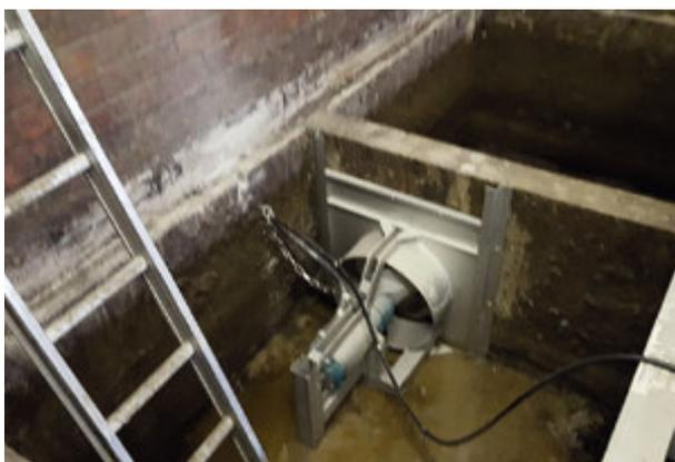
Mit einem Tauchmotorrührwerk können Schwimmdecken sicher aufgebrochen werden.
