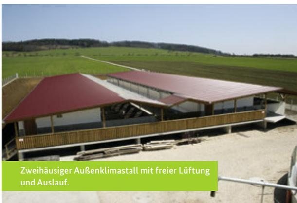
Zweihäusiger Außenklimastall mit freier Lüftung und Auslauf.
