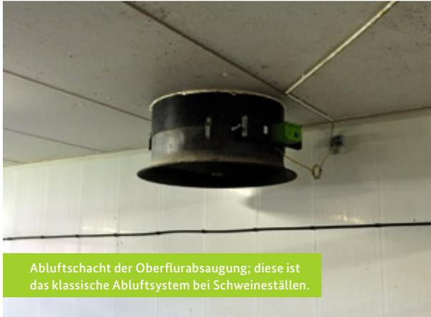
Abluftschacht der Oberflurabsaugung; diese ist das klassische Abluftsystem bei Schweineställen.
