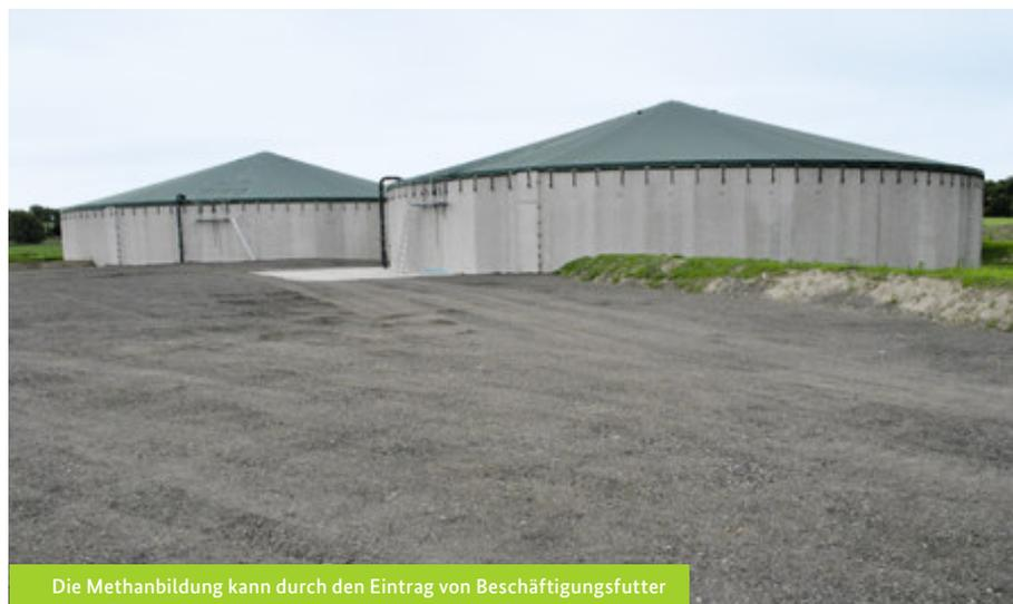
Die Methanbildung kann durch den Eintrag von Beschäftigungsfutter in die Gülle ansteigen, deshalb ist eine Güllelagerung außerhalb des Stalles mit Zelt Dach vorteilhaft.
